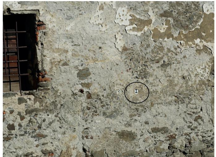
Abb. 8: Selbstklebende Passmarke an der Westfassade (Aufnahme Sulzer 2019).
