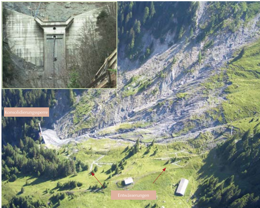
Abb. 6. Übersicht Massenbewegung Schönmoos-Hochalm mit Konsolidierungssperre hm 28,15 und Entwässerungssträngen
