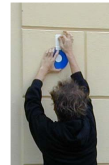
Anbringen einer retro-reflektierenden Zielmarke
